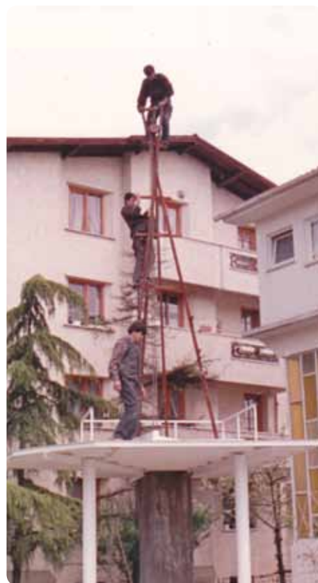
■ Se construiește un cadru pe care va fi montată antena
