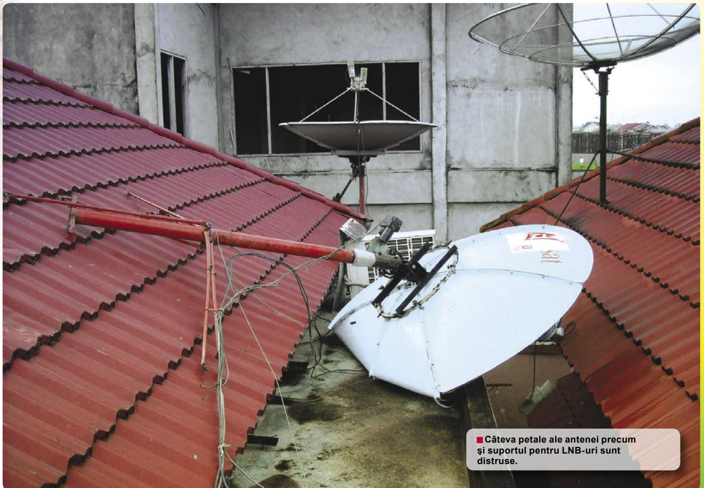
■ Dupa: ce rusine- antena de 1.8 m a cazut datorita rafalelor de vânt.
