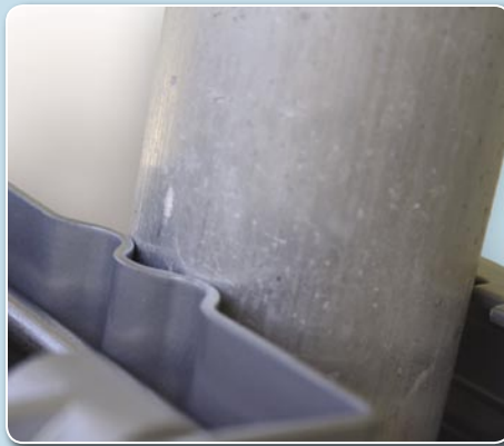
Marcaj pentru alinierea motorului pe pilon spre Sud
