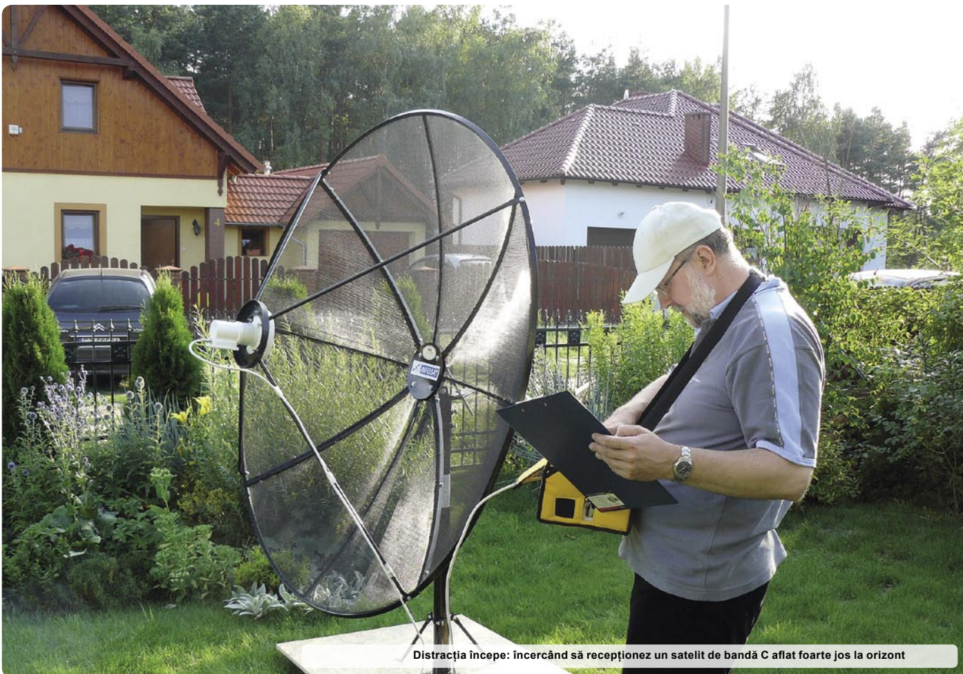
Este momentul alinierii antenei. Vă recomandăm să folosiți un poloboc echipat cu un măsurător de unghiuri –va face setarea elevației mult mai ușoară
